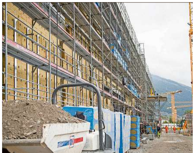
Der Zeitplan steht: Sobald die Rohbauphase diesen Herbst beendet ist, kann mit dem Innenausbau begonnen werden.
