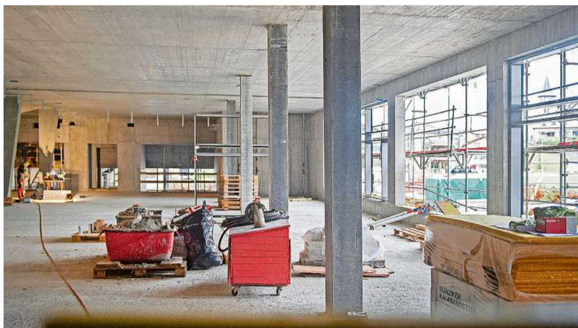
Beton so weit das Auge reicht: Für den Rohbau des Grosskinos wurden rund 7000 Kubikmeter Beton verbaut.
